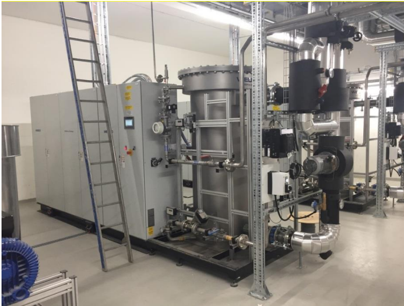
Abbildung 36: Beispiel eines Ozongenerators mit autonomer Steuerung
