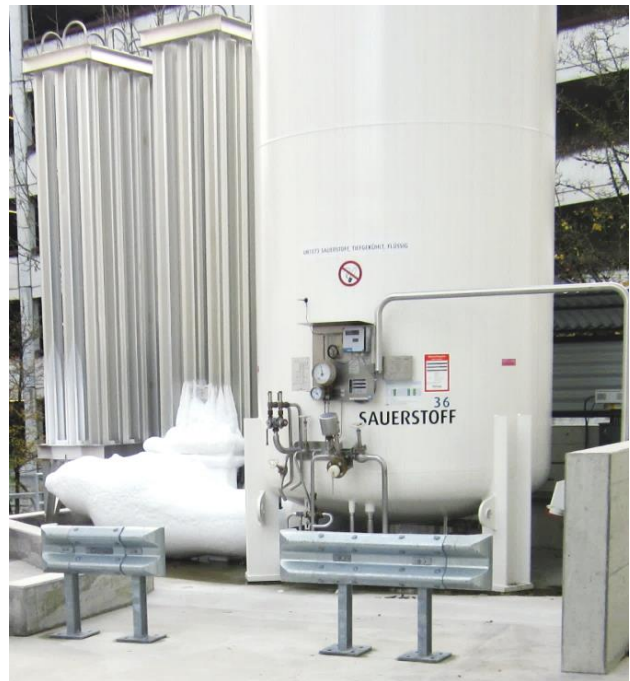
Abbildung 13: Beispiel einer Sauerstoff-Versorgungsanlage mit Tank (rechts) und Verdampfern (links) [ARA Neugut]
